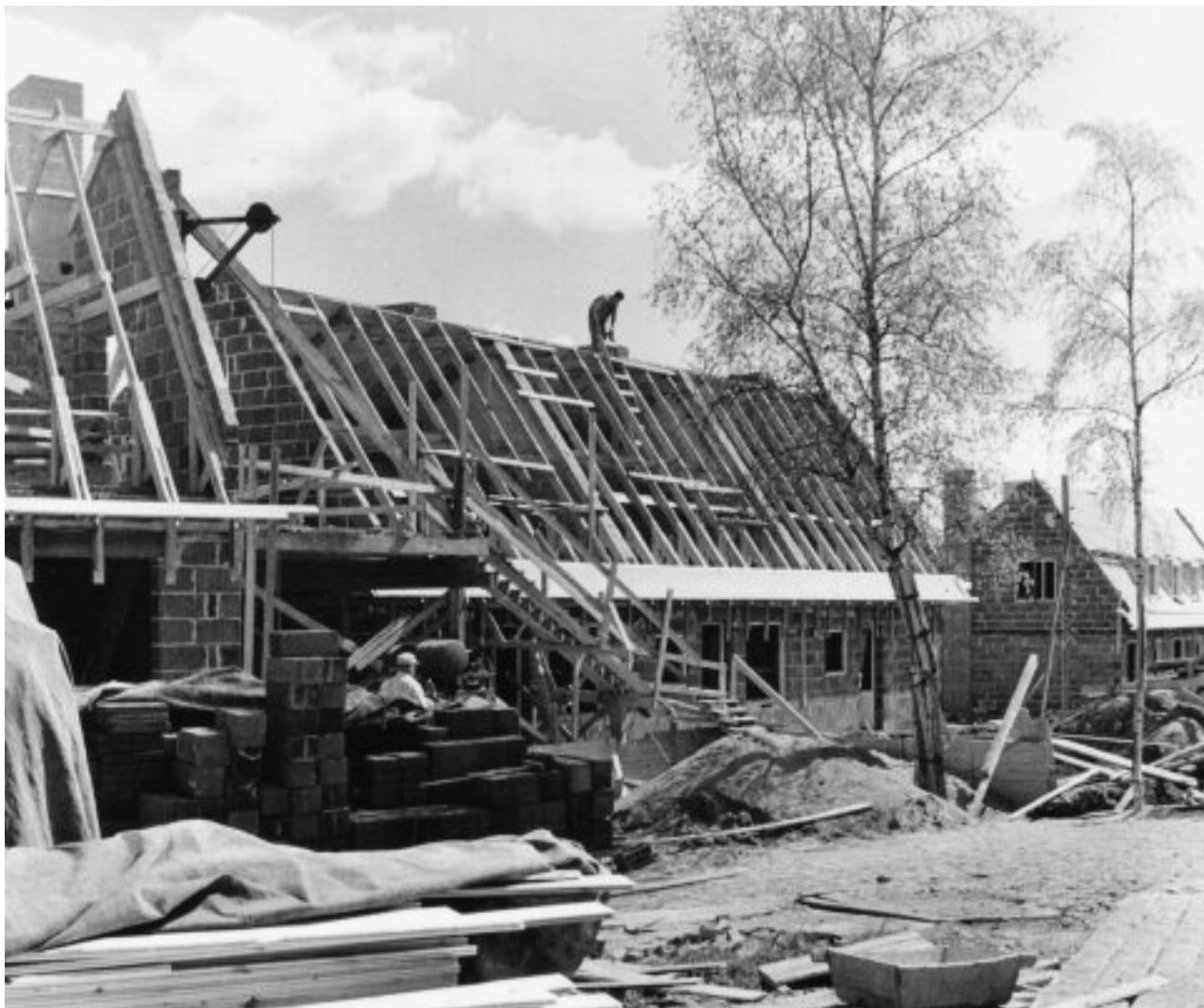
Byggarbetsplatsen våren 1951, hus 5 och 4 med hus 3 i bakgrunden. Foto K. Hammer, Stockholms Stadsmuseum
