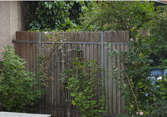
BEFINTLIGA PLANK MED STÅLRAM VID UTEPLATSER BYGGS OM EFTER ORIGINAL DIMENSIONER
